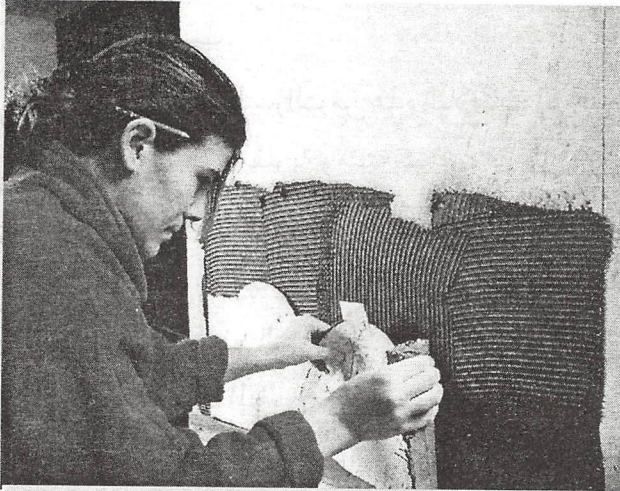
(شكل 87) تركيب لوحات الفسيفساء على ملاط صناعي ، أحد التدريبات العملية في مدرسة الفسيفساء في سيليمبرجو ، إيطاليا .
